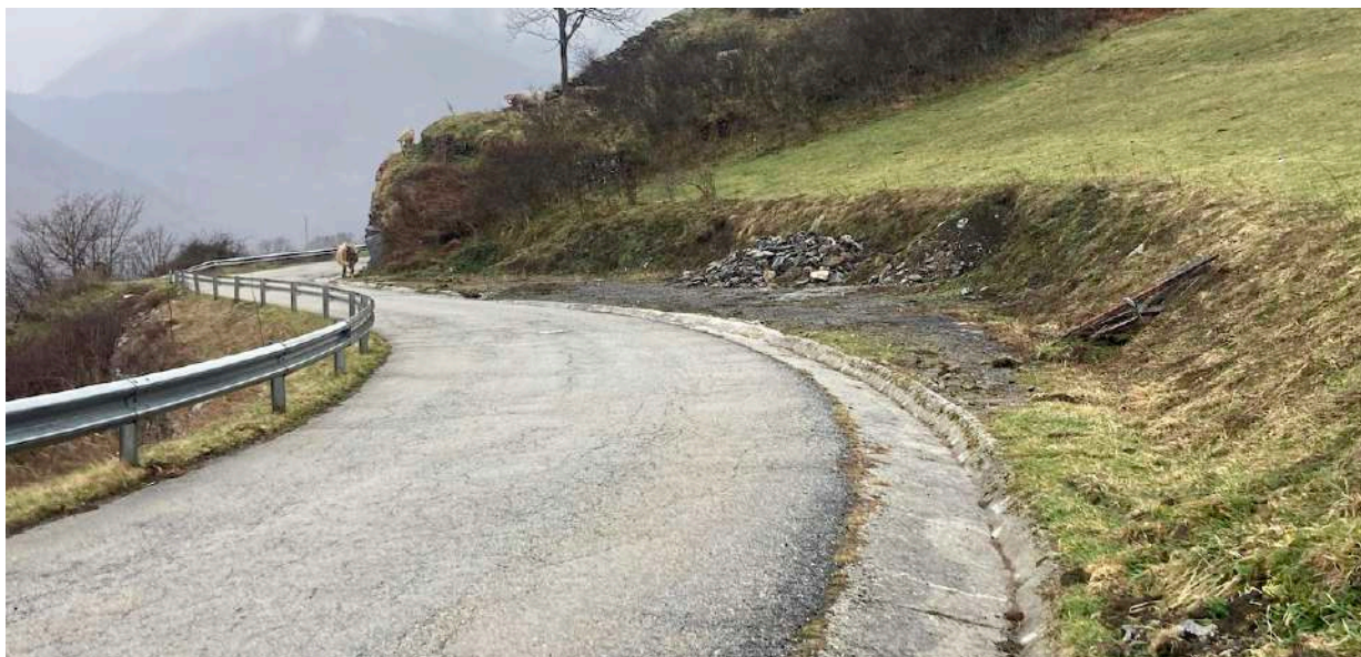
Vista de la Carretera a on es situa la zona d'actuació
