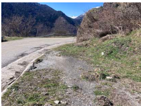
IMG 05. Vistes vers la vila i cuneta perimetral
